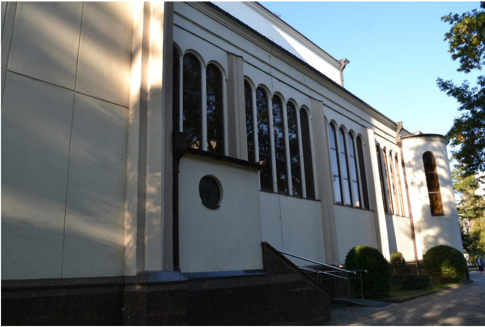
II. 73 Elewacja północna, widok na nawę boczną
