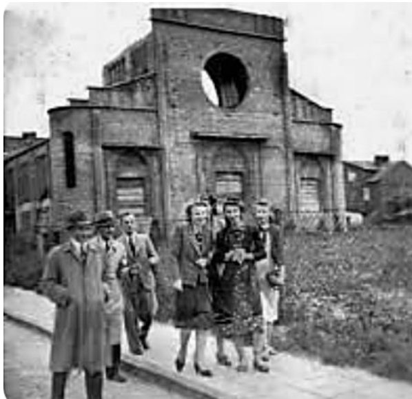
Il. 52 Budowa kościoła, 1947, Kościół pw. Chrystusa Króla, Atlas Warszawy waw.pl
