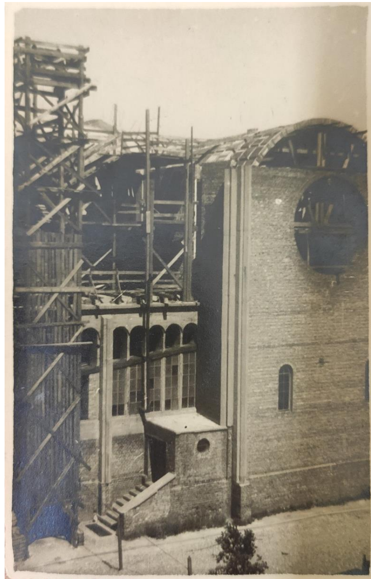
Il. 53-54 Budowa kościoła pw. Chrystusa Króla, prace budowlane – wykonanie sklepień kościoła fot. 1950, Archiwum Urzędu m.st. Warszawy
