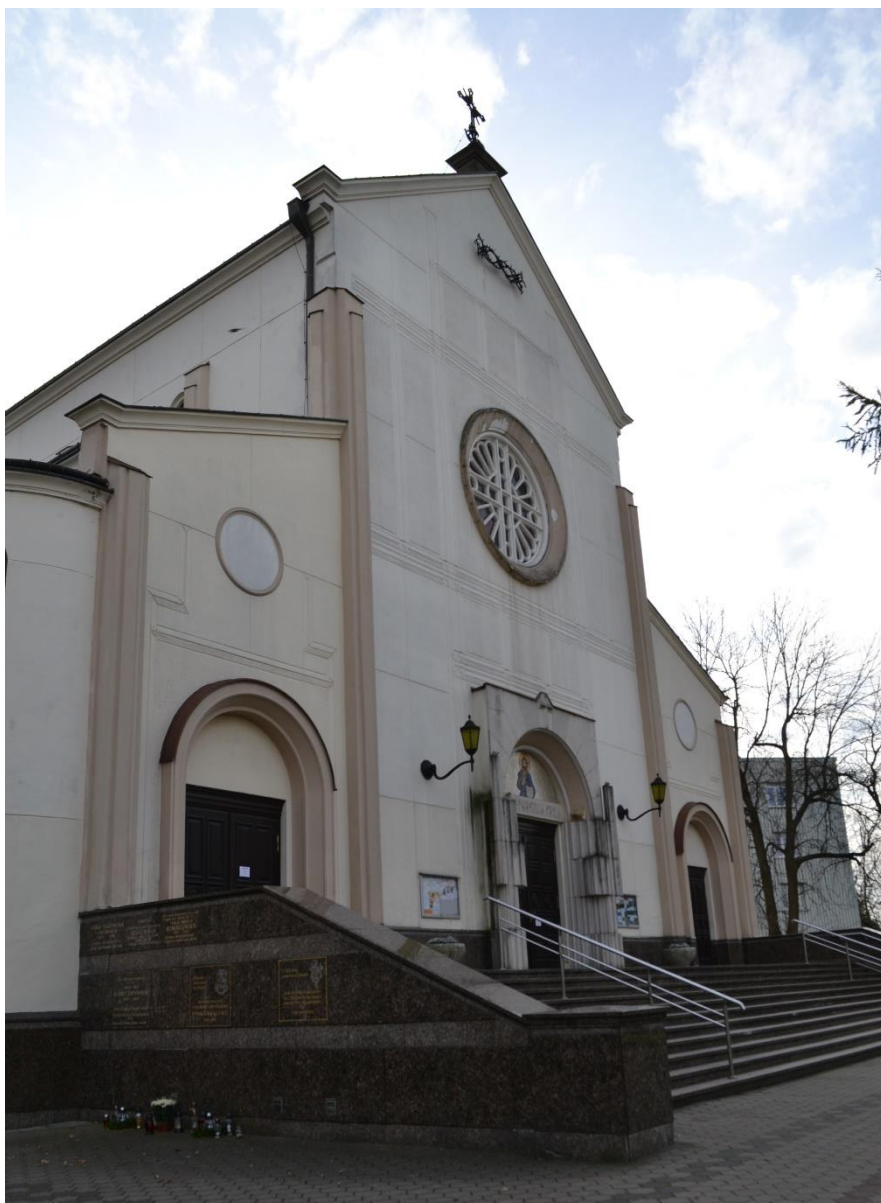
II. 69 Elewacja frontowa, widok na schody przed głównym wejściem
