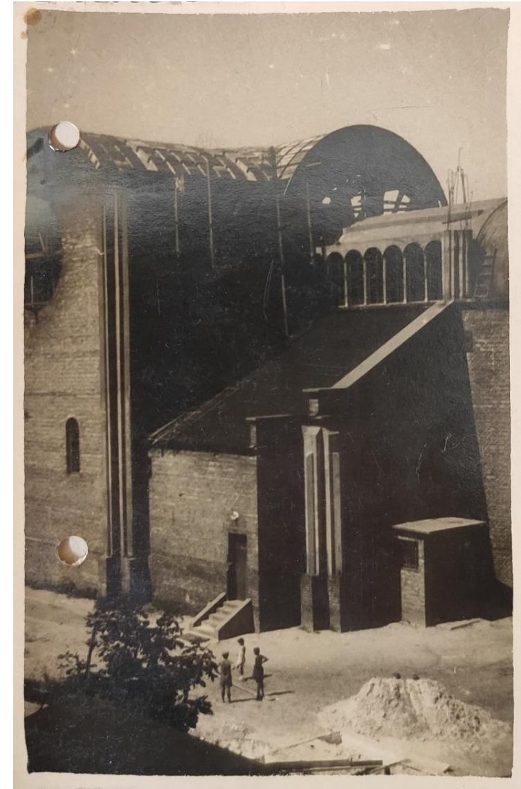
Il. 53-54 Budowa kościoła pw. Chrystusa Króla, prace budowlane – wykonanie sklepień kościoła fot. 1950, Archiwum Urzędu m.st. Warszawy
