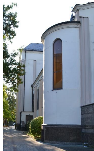
II. 71 Klatka schodowa
