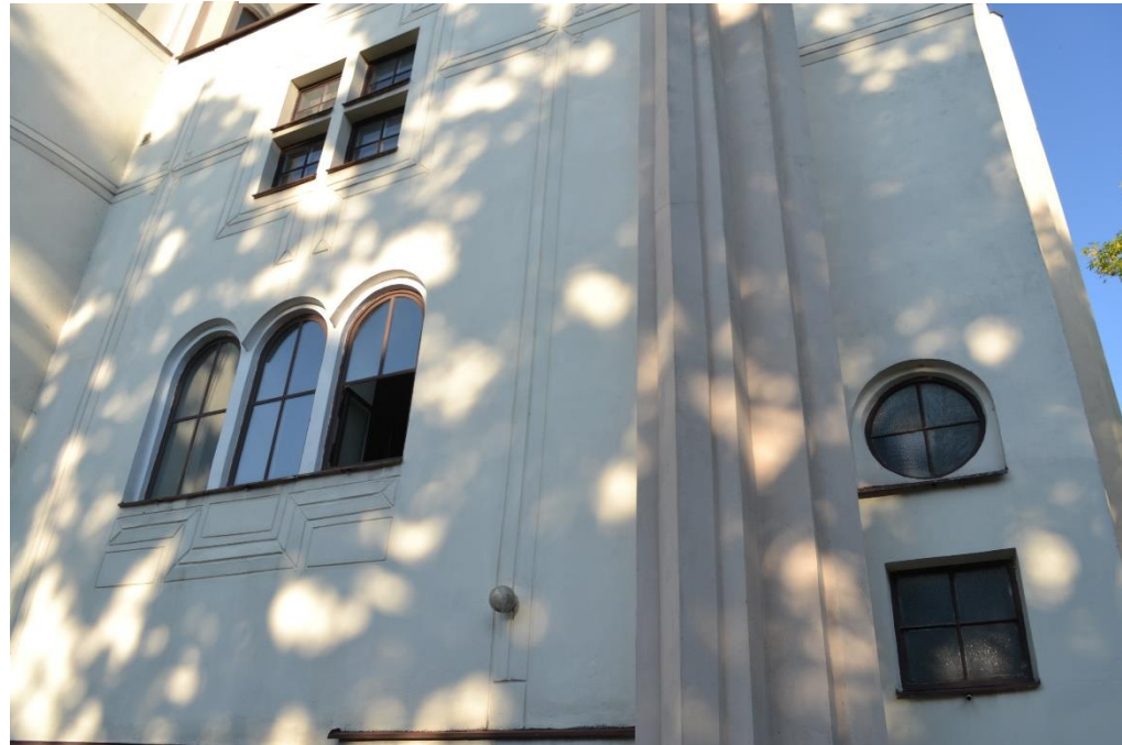
II. 76 Elewacja zachodnia, fragment aneksu
